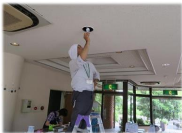
蛍光灯などを LED に交換
