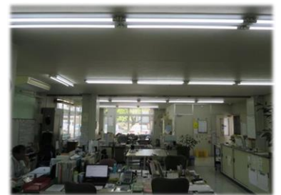
交換後の事務室
