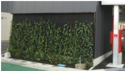
久留米市駅東口立体駐車場
