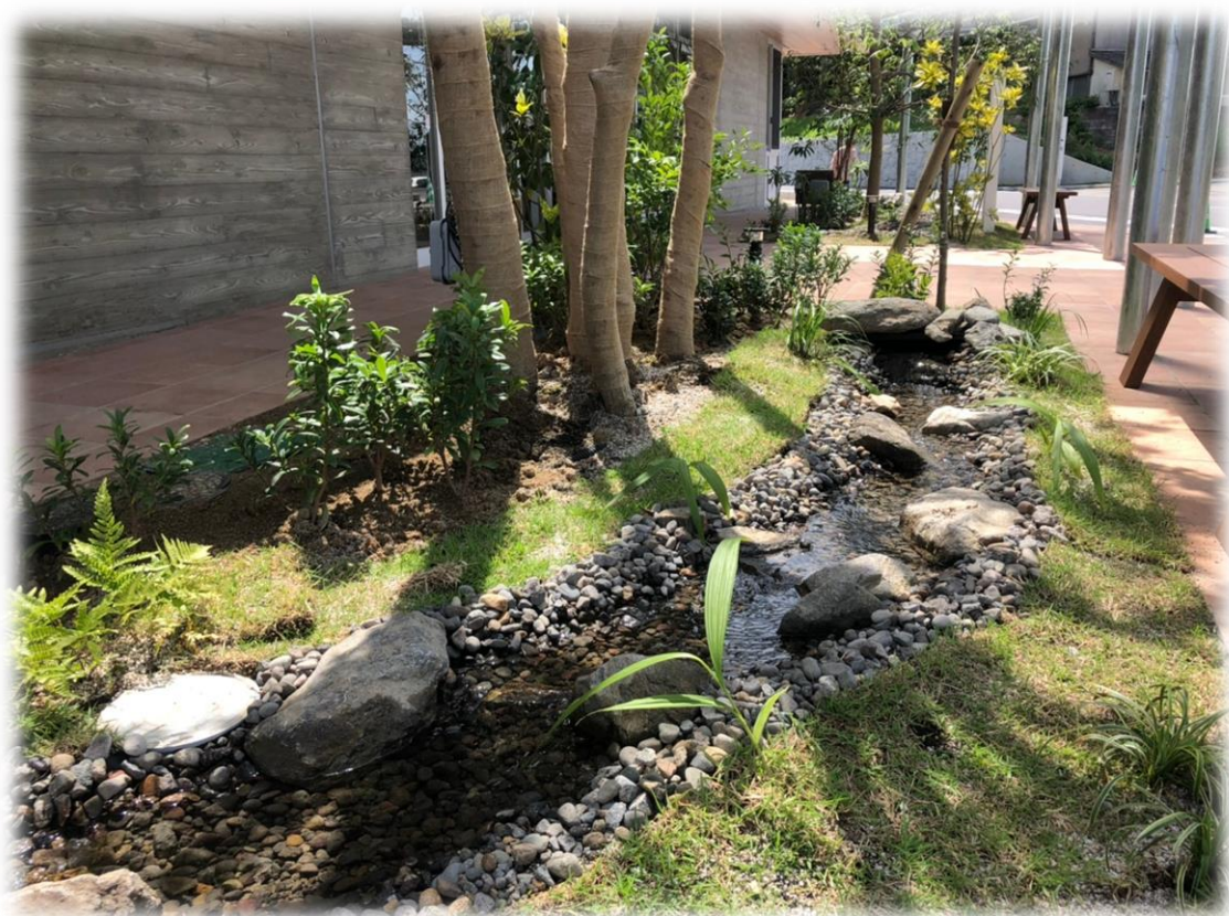
久留米某病院 植栽工事
