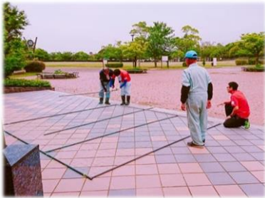
支柱の組み立て
