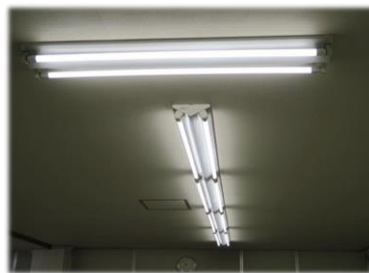
交換後の様子
